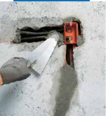
Fixation de boîtes et de fourreaux électriques avec Lampocem F
