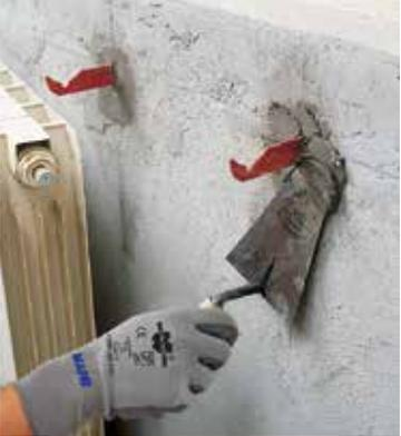
Fixation de supports pour radiateur avec Lampocem F
